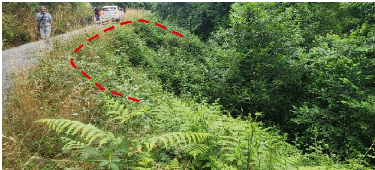
Figura 2: vista del dissesto principale, in rosso perimetro del fenomeno gravitativo
