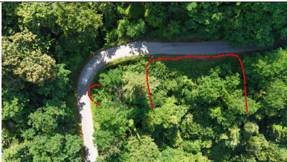
Figura 2: foto aerea con in rosso evidenziata area dissestata oggetto di intervento
